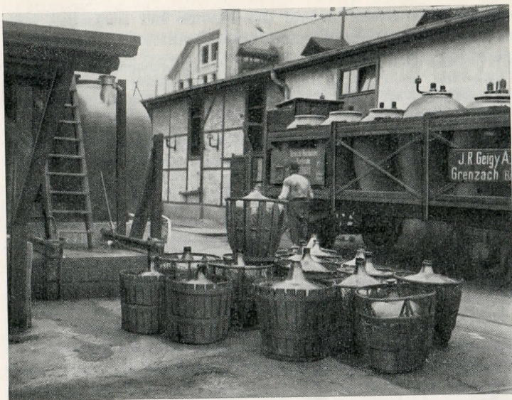
Alte Salzsäure-Speicheranlage bei Lokal 17; rechts Mono-Lagergebäude Lokal 19. (Photo Beerli, 1916.)
