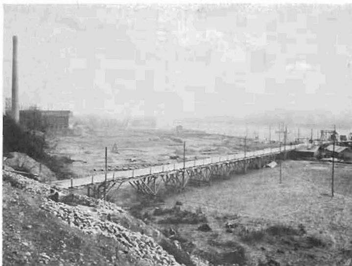
Abb. 80. Die Baustelle mit Dienstbrücke zum Stauwehr (1. XII. 08).
