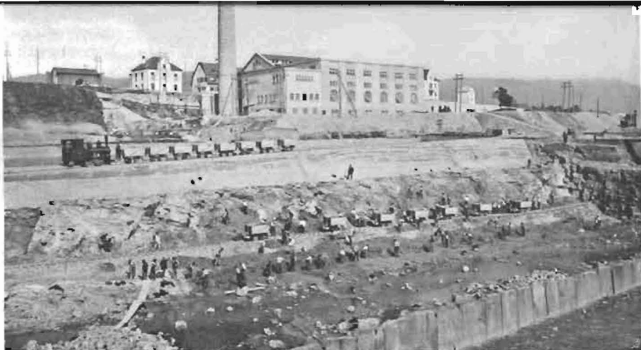
Abb. 81. Aushub des Unterwasserkanals (17. IX. 1909).
