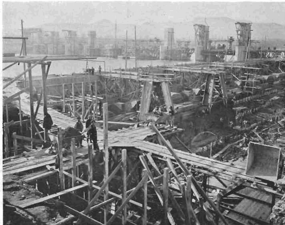
Abb. 83. Betonieren der Fundamente zu den Turbinenkammern und zum Generatorenhaus (25. II. 1910).
